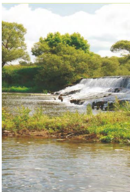
Slika 27 Brana u Brodskom Drenovcu (Izvor: Crnjac i Zelić, 2010 b)
