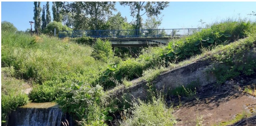
Slika 18 Most i stepenica na uzvodnom dijelu Glogovice unutar PEM (Rožac, 2022)
