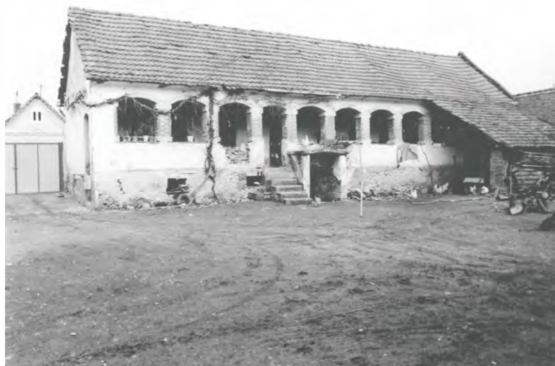
Stara kuća braće i zadruga Potočanac u Sokaku
