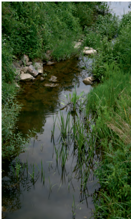
Slika 10. Kanal za odvodnju kod Bekteža
